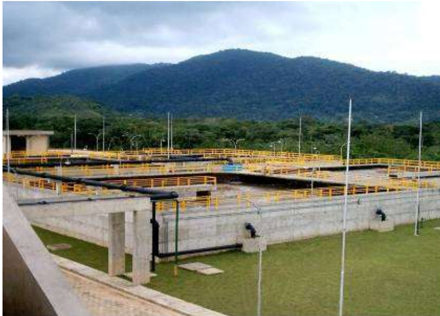
Foto 06 – Vista geral da Estação de Tratamento de Esgoto Principal (Fonte: SABESP)
