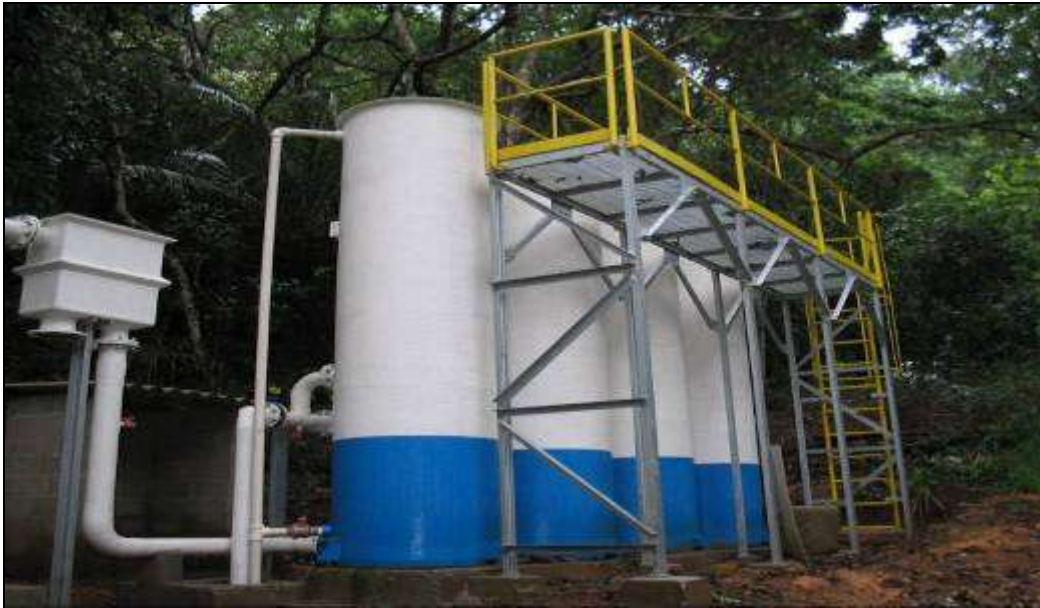
Foto 04 – Sistema de Filtração – Praia Vermelha do Sul (Fonte: SABESP)
