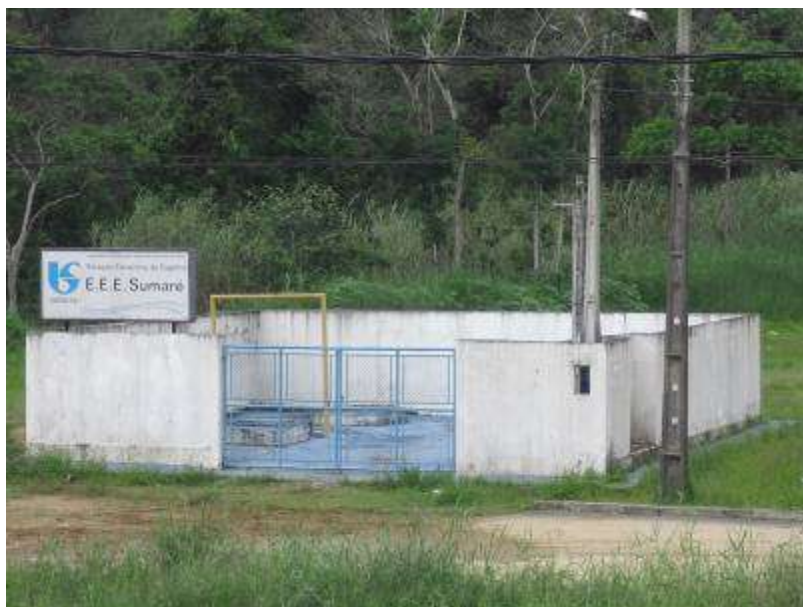
Foto 05 – EEE Sumaré – Sistema Principal
