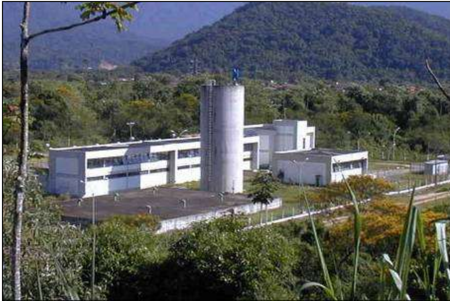
Foto 01 – Vista Geral da ETA Carolina (Fonte: SABESP)
