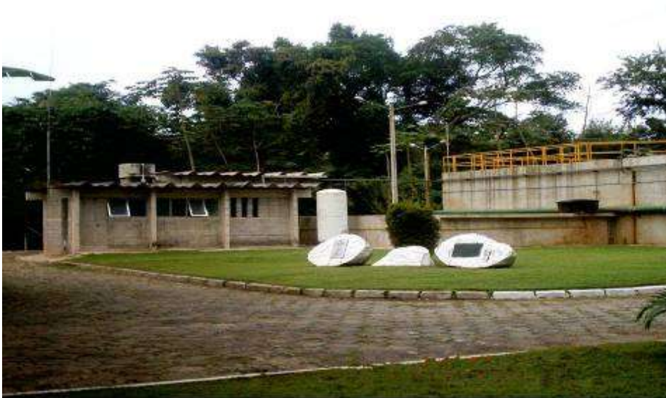
Foto 11 – Estação de Tratamento de Esgoto Toninhas (Fonte: SABESP)
