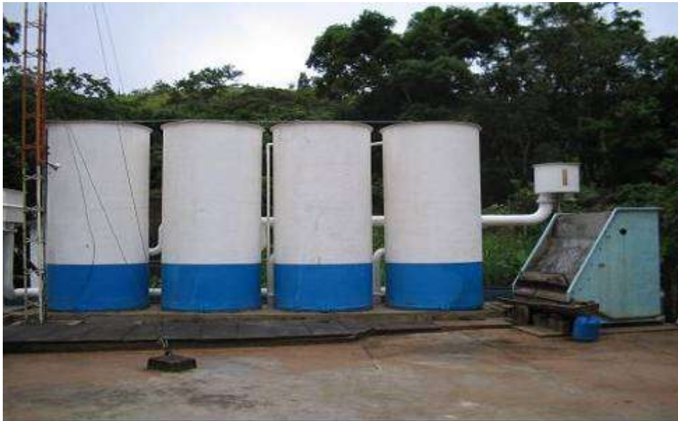
Foto 03 – Sistema de Filtração – Maranduba (Fonte: SABESP)
