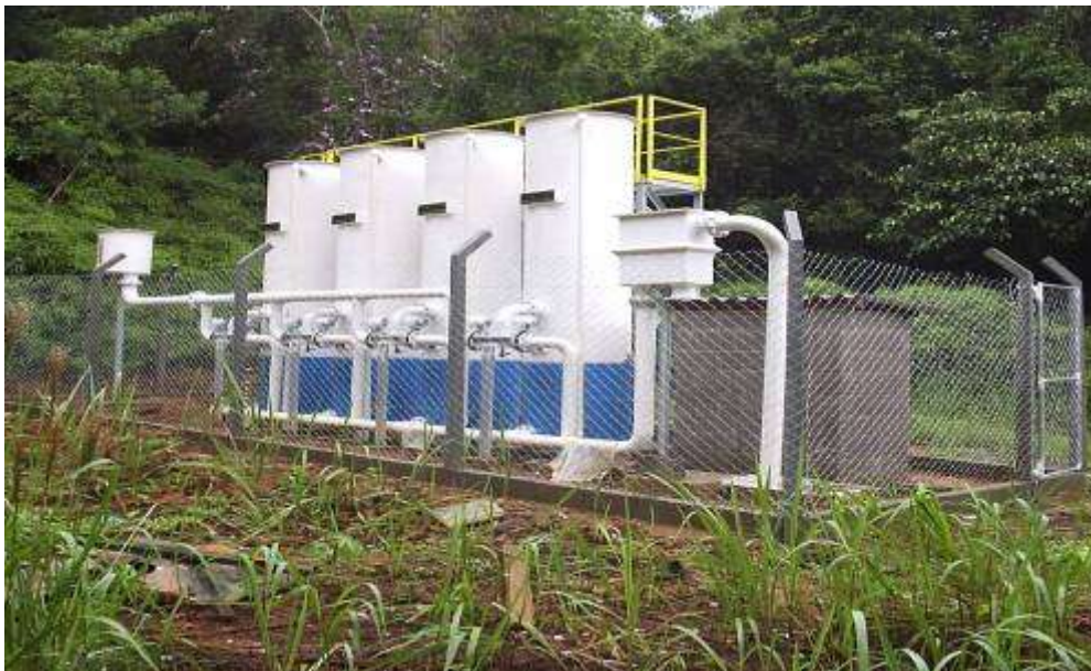
Foto 02 – Sistema de filtração – Itamambuca (Fonte: SABESP)
